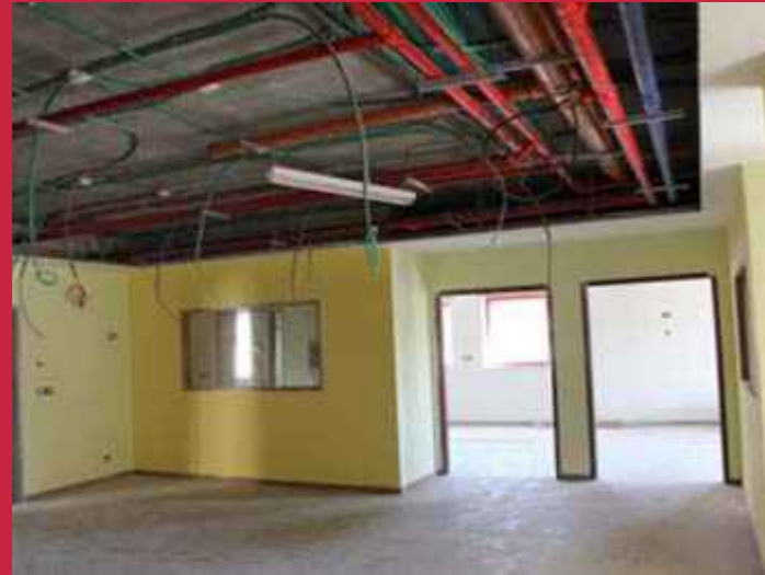
Innenausbau des LIFEGATE-Gebäudes
